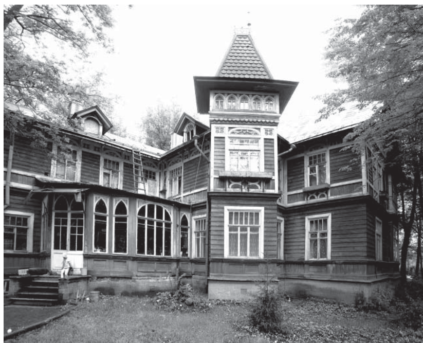
Дом сотрудников ВИР в г. Пушкине, Московское шоссе № 23. Веранда и окна в центре на первом этаже – летняя квартира Н.И. Вавилова, крайнее окно справа – квартира Г.Д. Карпеченко (Фото В. Уржумцева).
